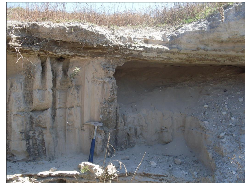
Figura 5.1.7.3. La erosión de capas inferiores menos competentes, puede provocar hundimientos y colapsos del terreno.
